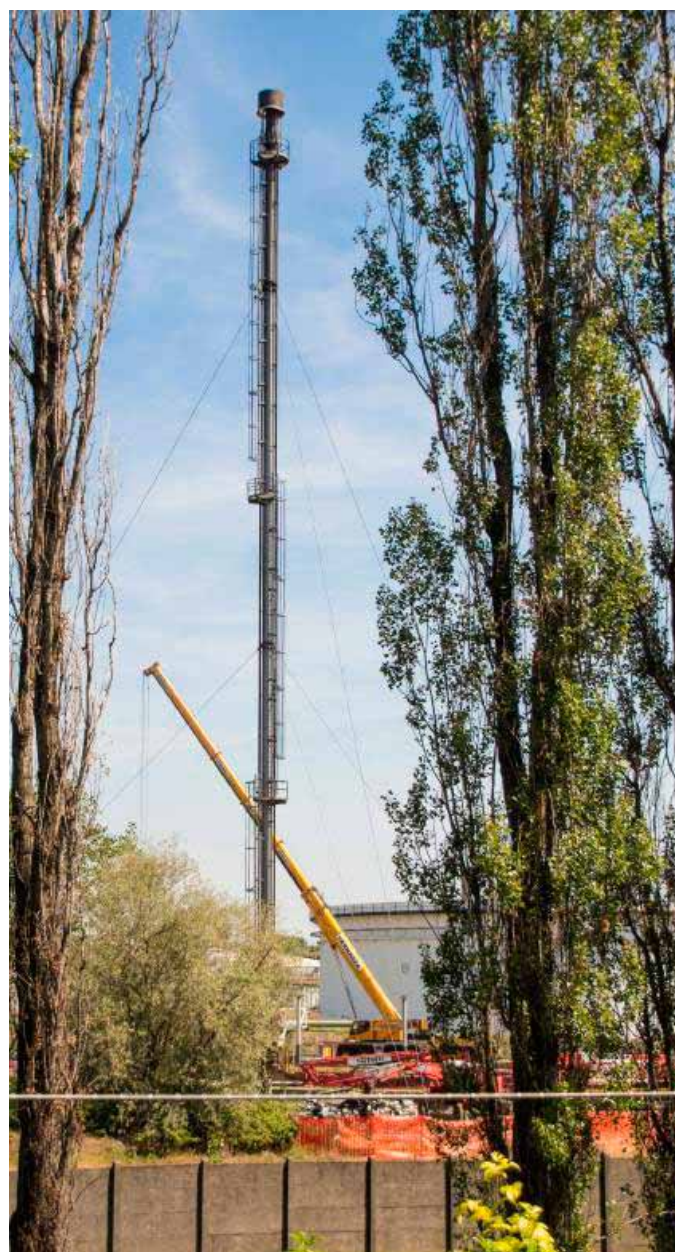
Lavori in corso all'interno della ex raffineria Tamoil
